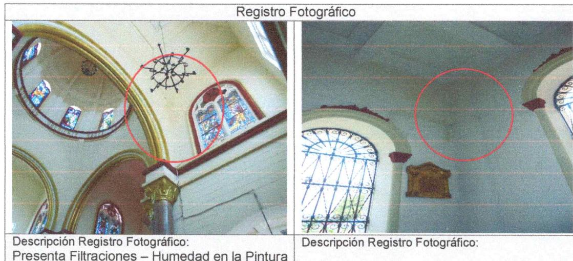
Lo que se puede dar por malos procesos constructivos utilizados como se evidencia a continuación, en donde se observa desprendimiento o rotura del manto.
